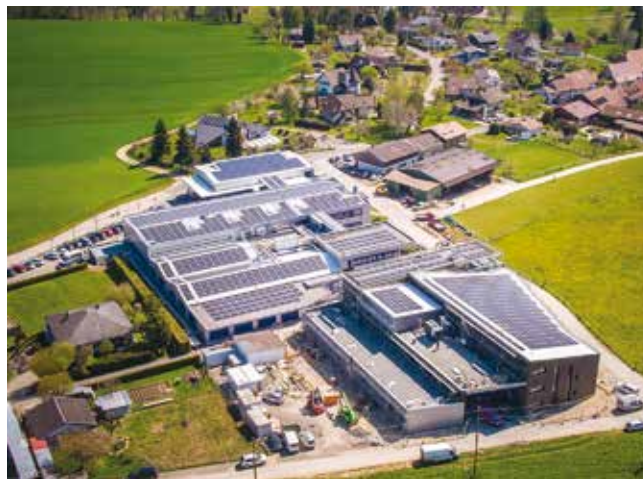
Une production plus propre grâce à une installation solaire conséquente. Au premier plan, le nouveau bâtiment qui sera opérationnel en octobre.
