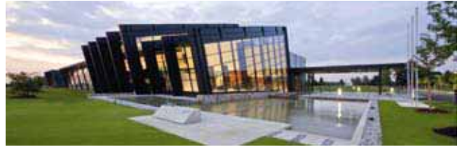
Vue sur le nouveau centre technique et de solutions de Amada à Haan. Ici aussi design et fonctionnalité sont harmonieusement combinés.
