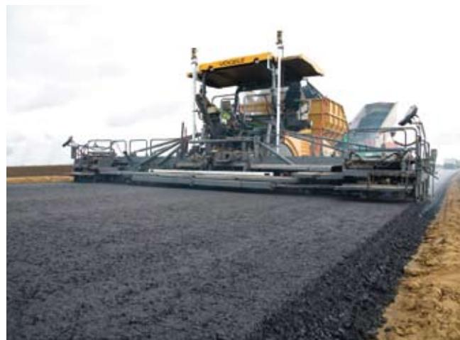
Travaux de revêtement sur gros chantiers : le nouveau système de pilotage 3D Navitronic® de Vögele utilise le GPS et remplace l'utilisation fastidieuse des fils conducteurs.
