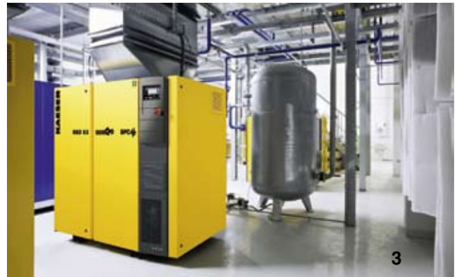
Une première mondiale pour les centrales BDS. Ces compresseurs performants sont les seuls du marché à posséder un moteur IE4 qui offre le rendement le plus élevé actuellement.
